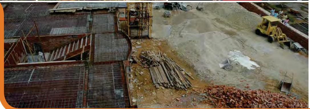
其後，我們再為已澆灌好的樓板作質量檢查時，又發覺工人的施工質素和那些以本土方法混出來的混凝土，並沒有想像般差劣。承建商再三表示自己經驗豐富，不停地說「那些『砵』以往都是這樣做的，沒有任何問題！」我們後來才知道，他們口中不停說的「砵」，原來就解作人工石，即香港的混凝土。
