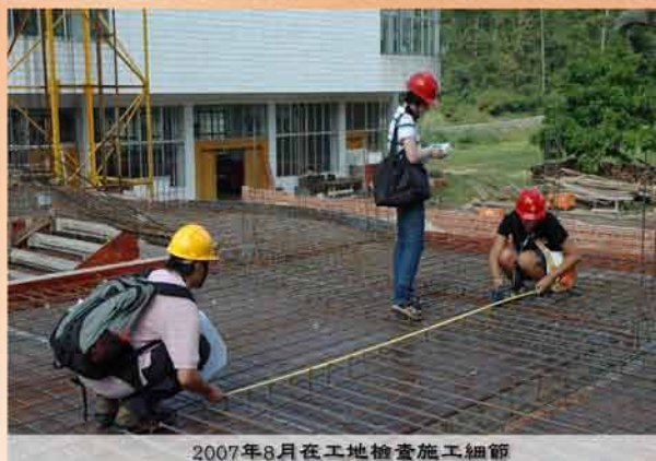
2007年8月在工地檢查施工細節
