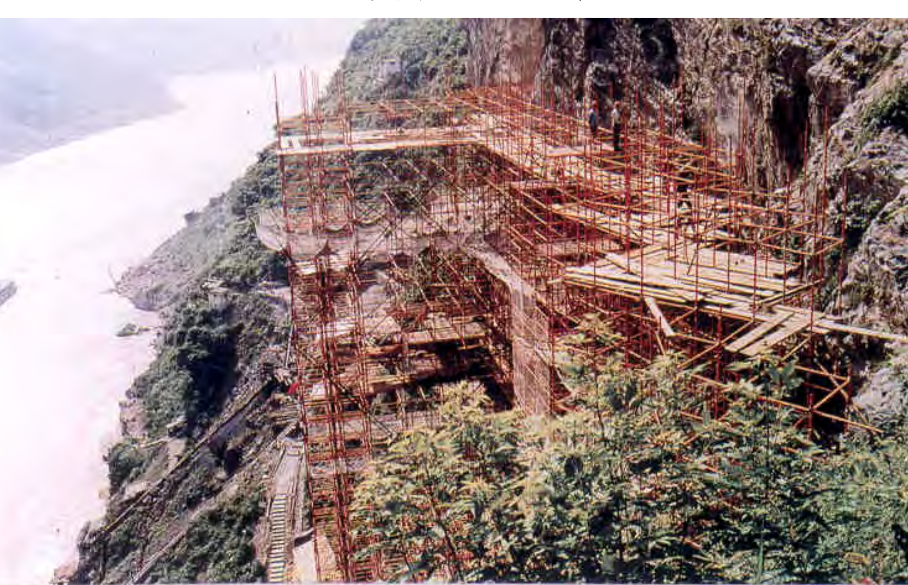
陡崖危岩體錨固工程施工排架俯視
