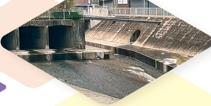
« Discharge of dry weather flows »
